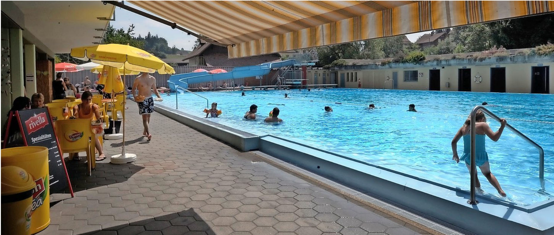
Gemütlich, aber in die Jahre gekommen: Die Huttwiler Badi muss saniert werden. Dabei wird auch ein Neubau an anderem Standort geprüft. Foto: Walter Pfäffli
